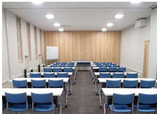
カラマツ材による内装（市団地集会所）
