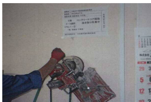
コンクリート強度検査コア採取
