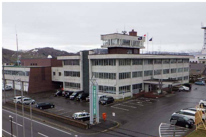
耐震補強が必要な老朽した総合庁舎
