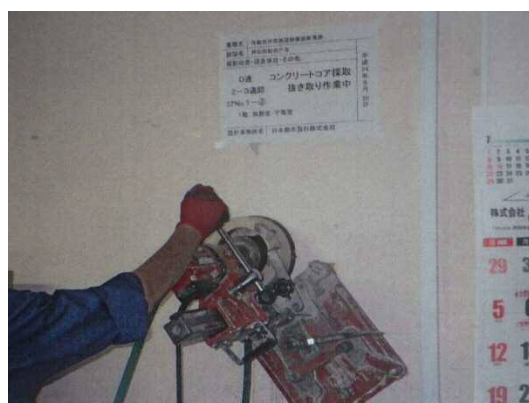
コンクリート強度検査コア採取
