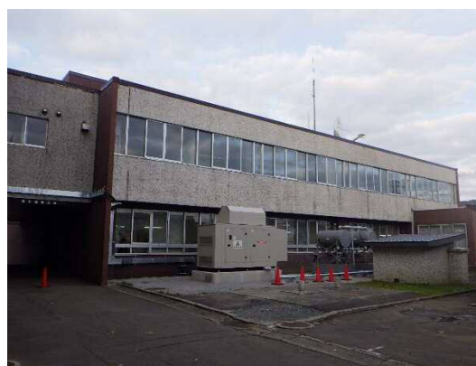
旧消防・議会棟（南面）
