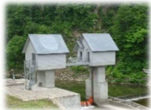
【西芦別浄水場取水口】
