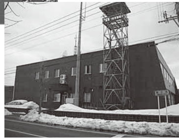
老朽化し手狭な現在の消防庁舎
