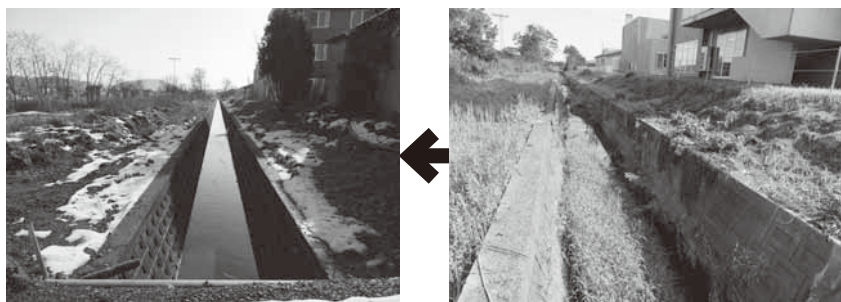
桜川都市下水路（現在の名称は空知川1の1号幹線）の施工前（写真右）と施工後
